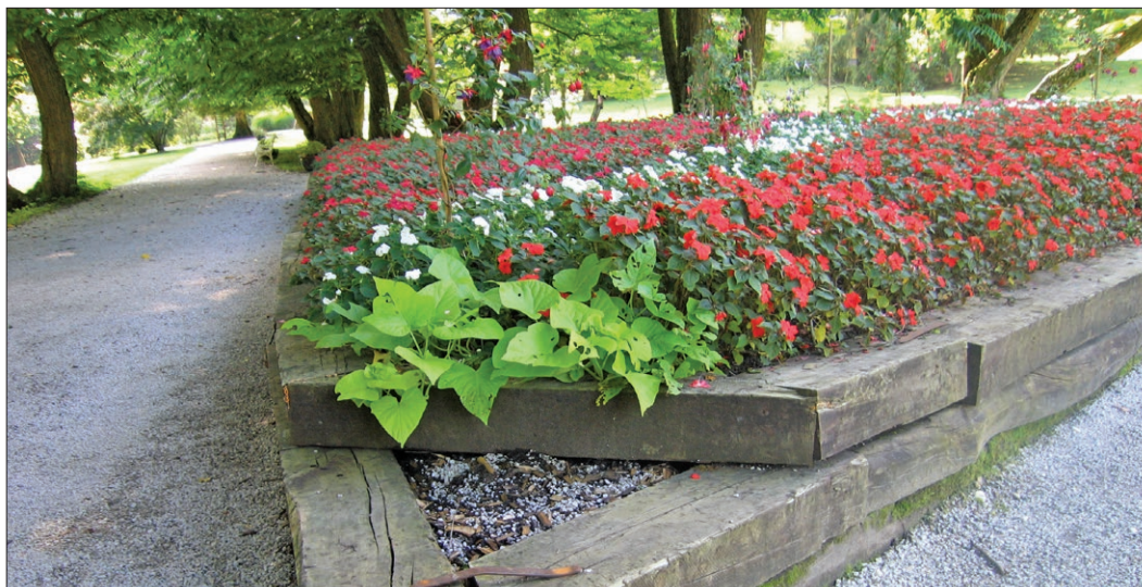
Slika 4: Primer ponovne rabe odsluženih železniških pragov (foto: M. Humar)
