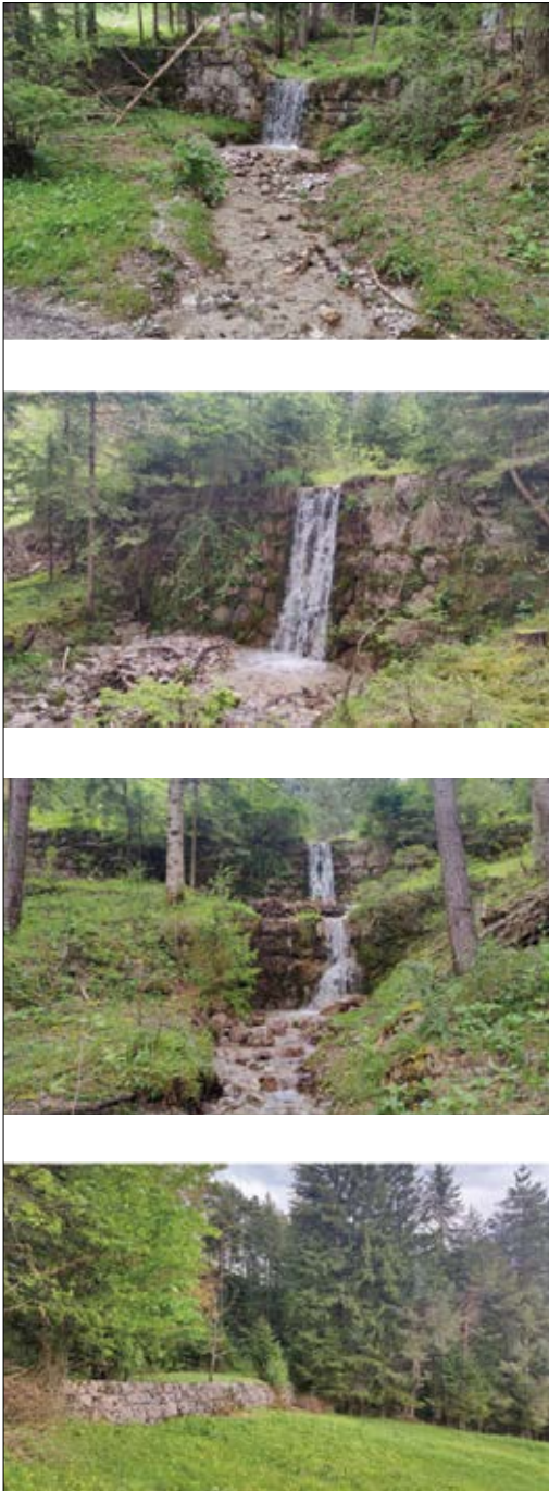
Slika 2: Pregrade na zahodnem pritoku Dovškega potoka tik nad vasjo, zgrajene leta 1954. (Foto: B. Mekina) Figure 2: Barriers on the western tributary of the Dovški potok stream just above the village, built in 1954. (Photo: B. Mekina)
